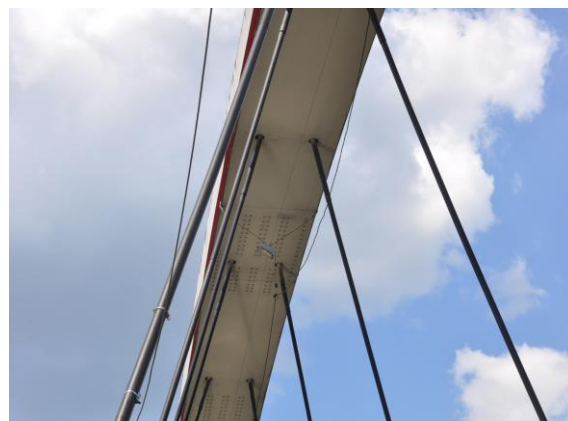
Fot. 6. Widok wieszaków stalowych
