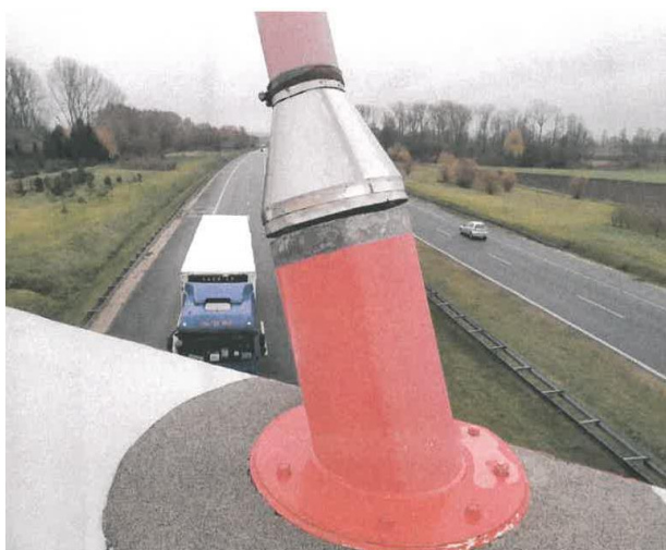
Fot 11. Przesunięcie osłony ciągnien
