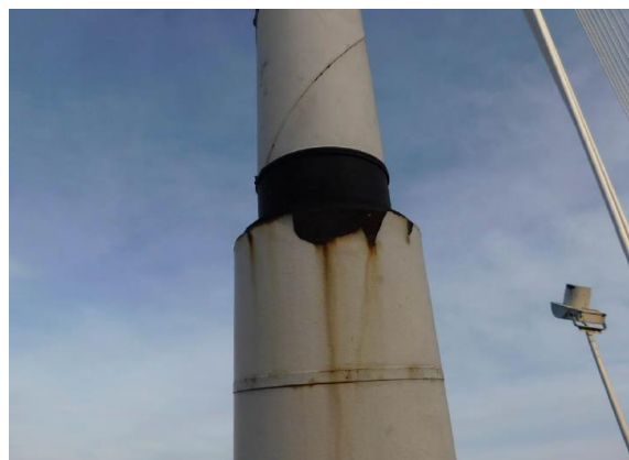
Fot. 3. Miejscowe uszkodzenia malarskich powłok ochronnych stalowych elementów zakotwienia want wraz z ogniskami korozji w obrębie osłon, powodującymi deformację i pęknięcia
