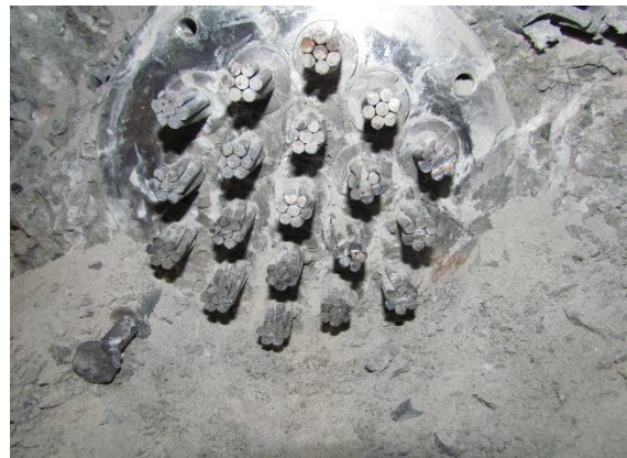
Fot. 2. Przykład zabezpieczenia strefy zakotwień poprzez obetonowanie (widok po skuciu betonu, brak uszkodzeń korozyjnych)
