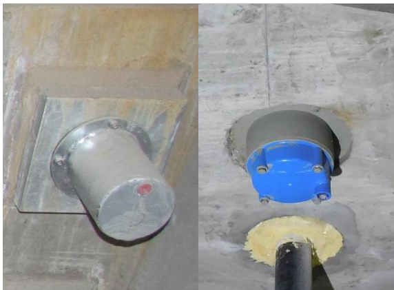
Fot. 1. Przykład zabezpieczenia strefy zakotwień, po lewej ocynkowana płyta oporowa i stalowa ocynkowana osłona zakotwienia, po prawej osłona z tworzywa sztucznego i powłoki malarskie (brak uszkodzeń)
