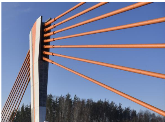
Fot. 8. Ciężna podwieszająca bez uszkodzeń
