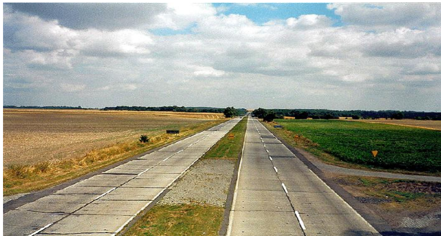
Widok nawierzchni A18
