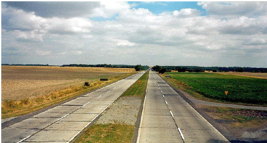
Widok nawierzchni A18
