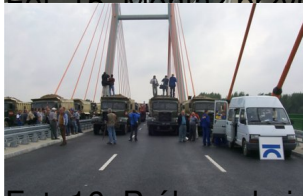
Fot. 16. Próbné obciążenie mostu Siekierkowskiego w Warszawie (2002 r).
