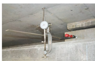
Fot. 8. Pomiar ugięć zastosowaniem metody komputerowo-wizyjnej.
