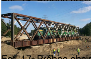
Fot. 17. Próbné obciążenie tymczasowego wiaduktu typu KD-66c we Włocławku (2004 r).
