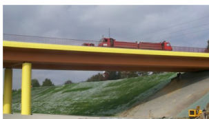
Fot. 14. Próba obciążeniowa jednego z wiaduktów nad autostradą A4 - Południowe obejście
