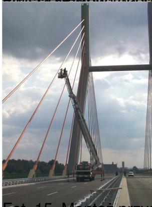
Fot. 15. Montaż przyspieszeniometry na linach mostu Siekierkowskiego Warszawie (2002 r).
